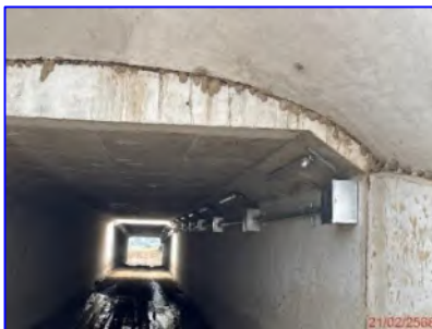
ภาพที่ 5.2.6-3 ไฟส่องสว่างบริเวณทางลอด กม.40+100
