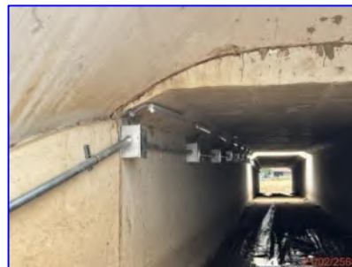
ภาพที่ 5.2.6-3 ไฟส่องสว่างบริเวณทางลอด กม.40+100
